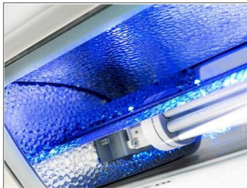
L'éclairage LED a été intégralement incorporé dans le luminaire. Son raccordement doit être fait de telle façon qu'il ne puisse être allumé qu'une fois l'éclairage primaire éteint. L'intensité de l'éclairage LED peut également être variée de façon progressive, pour l'adapter aux besoins.
