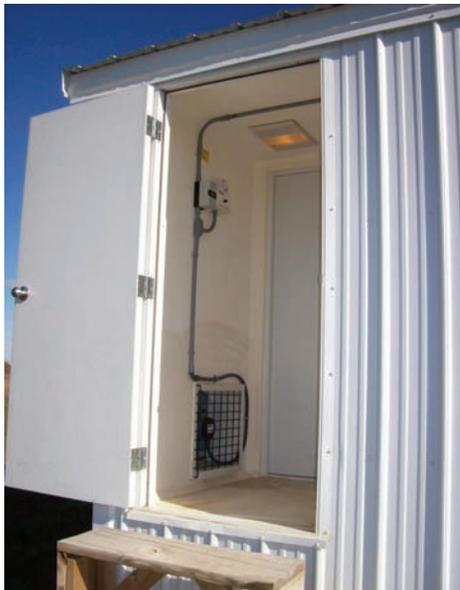
*Vista del ventilador de la cámara*
